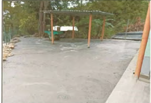
Foto 2: Proceso de construcción y entortado para área de cocina, finalizado en su totalidad.
