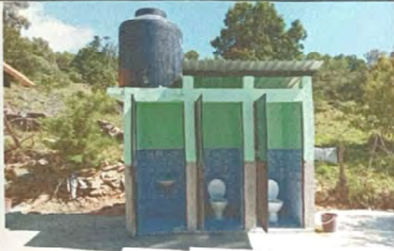
Foto 5: Reparación de servicios sanitarios y cambio de accesorios, lava manos, Rotoplast y Tubería PVC, finalizado en su totalidad
